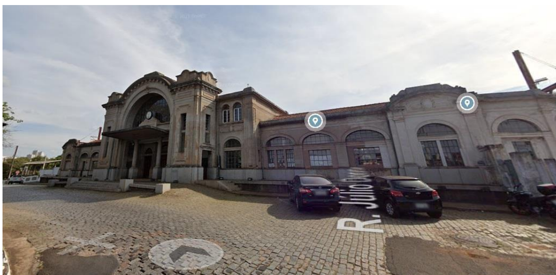
Figura SEQ Figura \* ARABIC 37– Estação Ferroviária
